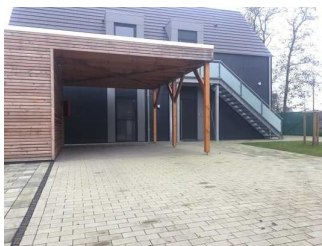
Parkplatz vor dem Haus
